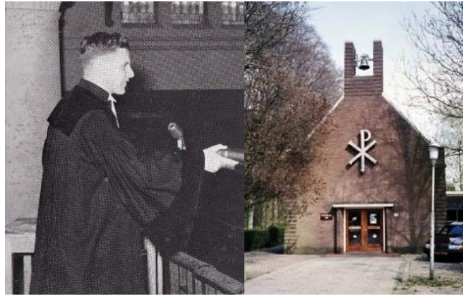
Ds. Wiersinga (foto: '25 jaar Gereformeerde Kerk in Schagen'). De gereformeerde kerk te 's-Graveland na de verbouwing in de jaren '50.
